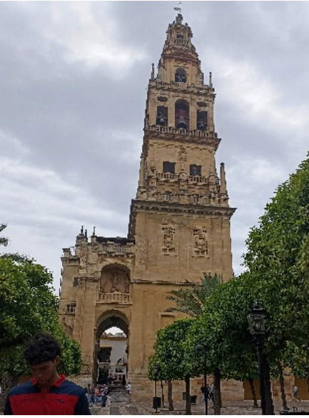
(RESİM 14) KURTUBA CAMİİ'NİN ŞİMDİ ÇAN KULESİ OLAN MİNARESİ
